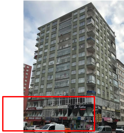
Şekil 9: Örnek Yumuşak Kat Bulunan Yapı
