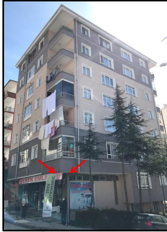
Şekil 8: Örnek Kısa Kolon Bulunan Yapı
