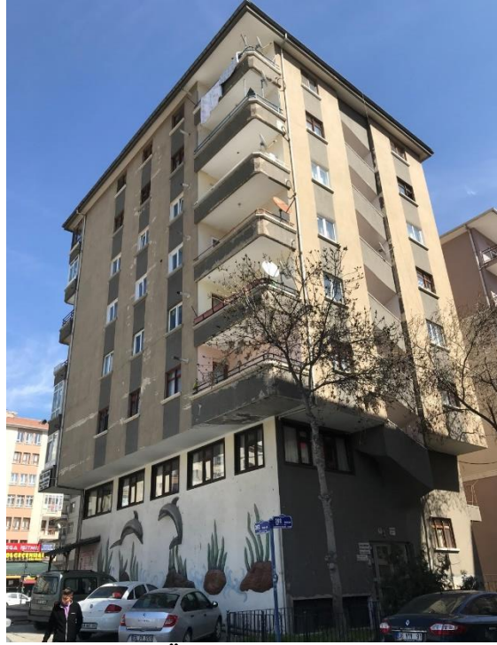
řekil 7: rnek Ađır ıkma Yapı
