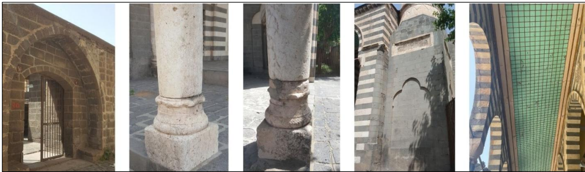
Şekil 7. Dış duvarda, sütunlarda, ayakta ve son cemaat bölümünde meydana gelmiş malzeme kayıpları (Budak,2023)
