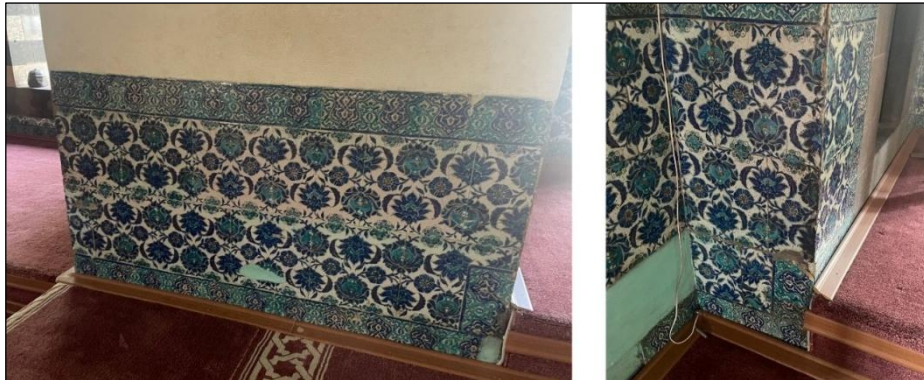
Şekil 9. Duvar seramiklerindeki kayıplar (Budak,2023)
