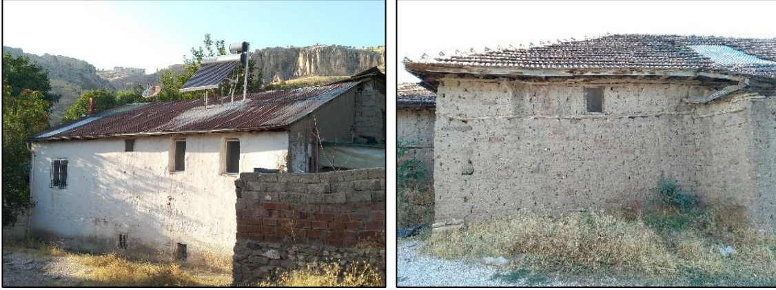
Şekil 9. Elazığ Hüseyinik(Ulukent) Mahallesi'ndeki Kerpiç Evlerdeki Çatı Eklentileri
