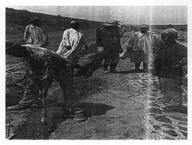
GROUP R MISCELLANEOUS PROTECTION WORK ; CONCRETE TOP EDGE BEAM ALONG THE MAIN DAM ENCAPSULATION BERM.
