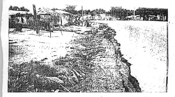
PARTIALLY ERODED ROAD SURFACE DUE TO LACK OF PROPER DRAINAGE.
